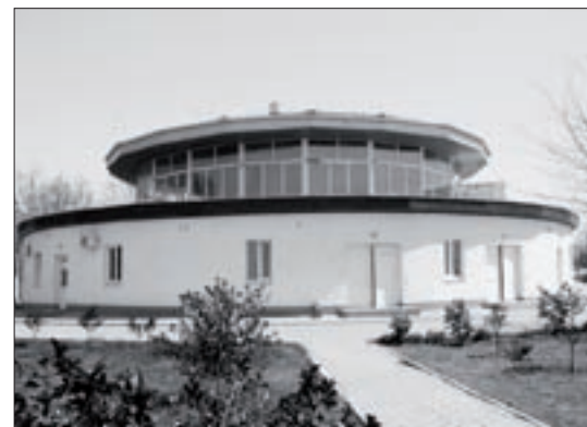
Фото: ГУПС «Водоканал»
